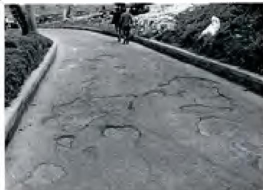
Foto 3: Fisuras y Grietas en Bloque. Se evidencia agrietamiento que divide el pavimento en trozos aproximadamente rectangulares de diversas dimensiones.
