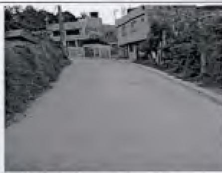
**Foto No 7:** Se evidencia la diferencia en la calidad de los materiales y la inadecuada terminación de la superficie y/o carpeta asfáltica.
