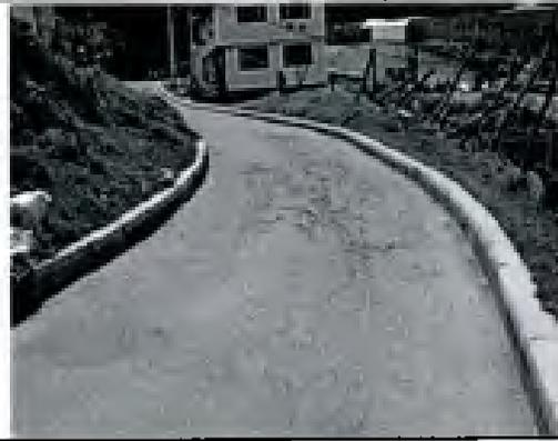
Foto No 2: Fisuras y Grietas en Bloque. Se evidencia agrietamiento que divide el pavimento en trozos aproximadamente rectangulares de diversas dimensiones.
