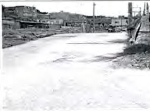
Foto 8: Fisuras y Grietas en Bloque. Se evidencia agrietamiento que divide el pavimento en trozos aproximadamente rectangulares de diversas dimensiones.
