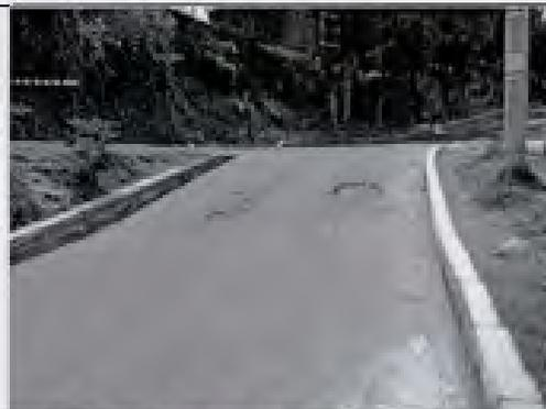
**Foto No 6:** Se observan las deficiencias constructivas en la colocación de la carpeta del material de fresado. Según inspección visual se observa una falla funcional debido a la incapacidad del pavimento para proveer una superficie que permita un rodaje de los peatones y/o vehículos confortable.
