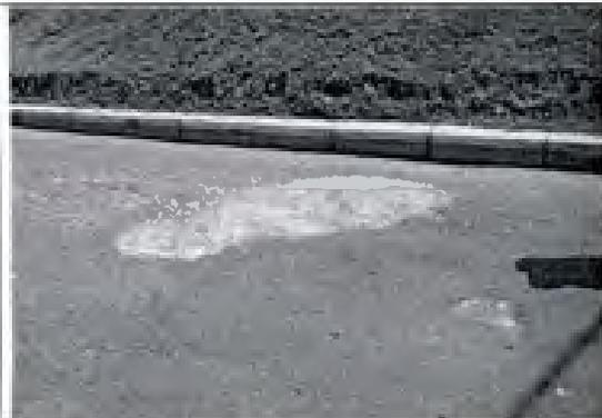
Foto 7: Fisuras y Grietas por Fatigamiento. Se observa una serie de fisuras y grietas interconectadas entre sí, en una etapa muy avanzada de deterioro formando una "malla de gallinero" o "piel de cocodrilo", en todo el segmento.
